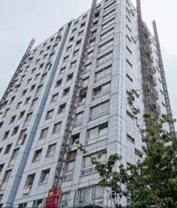
Wohngebäude vor der Sanierung Residential building before the renovation
