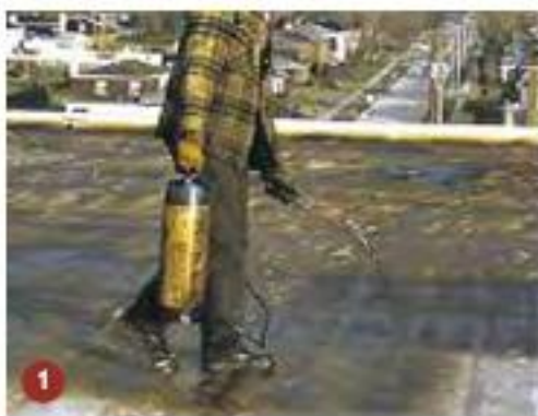
1 Spraying Alumasc Bitumen Primer
